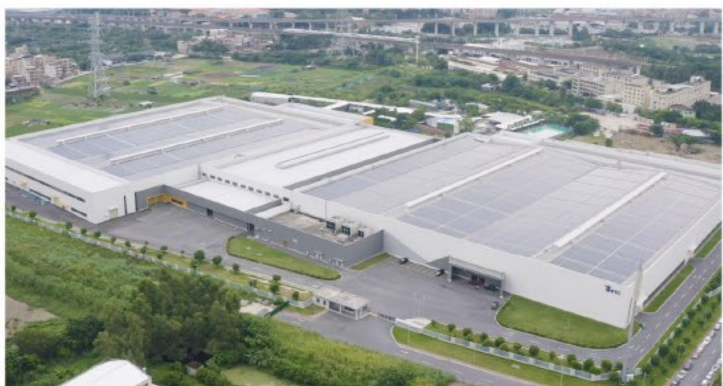
屋顶光伏发电系统
